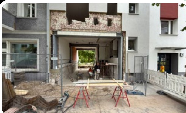
Bau der Hofdurchfahrt Hasselwerderstr. 6 – 8
