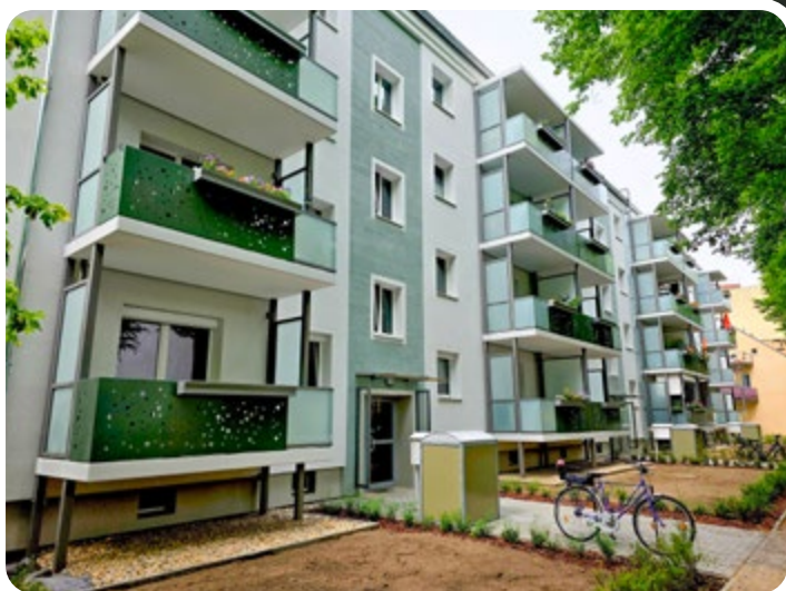
Neue Fassade der Stienitzseestraße 8 – 12
