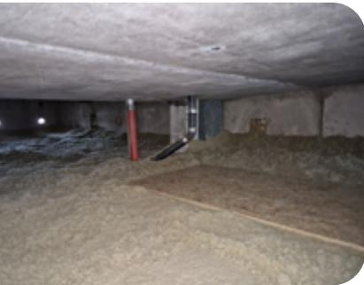
Die **Drempeldämmung** in der *Schmidstr. 5–7* musste aufgrund von Taubennestern und damit verbundenem Ungezieferbefall komplett erneuert werden. Jetzt ist alles wieder in bestem Zustand.
