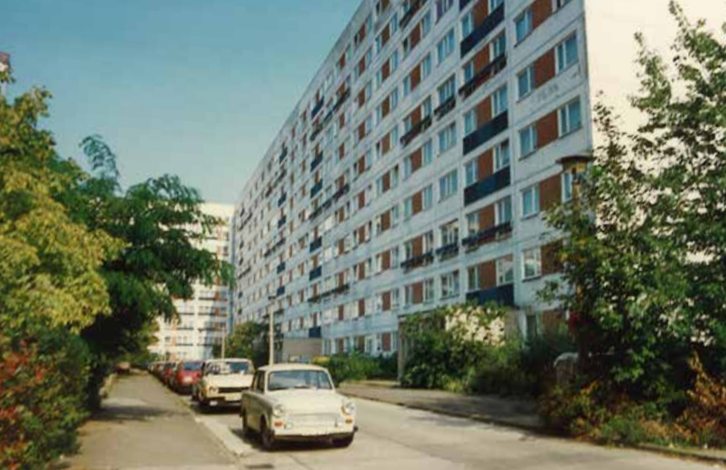
Michaelkirchstr. 24–30 in den 1990er Jahren
