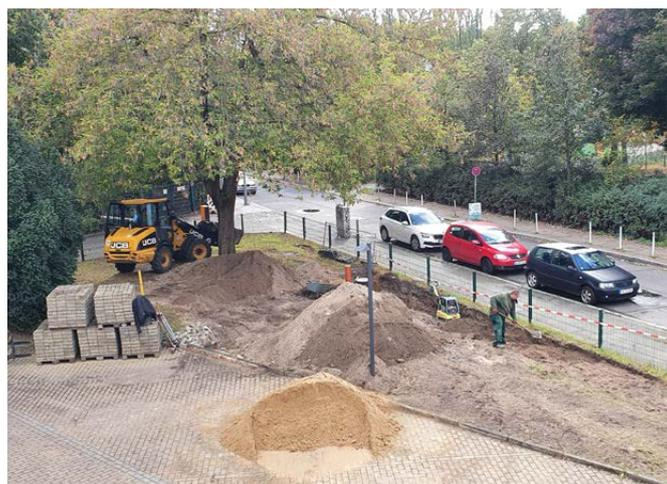
Einbau einer Rigole bei der Geschäftsstelle, um das Regenwasser dem Naturhaushalt direkt wieder zuzuführen. Dies trägt zum Erhalt des Grundwasserhaushalts und der Bodenaktivität bei, auch werden die natürliche Verdunstung und damit das Stadtklima gefördert und verbessert.
