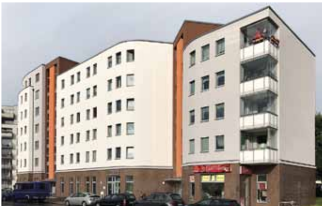
Heinrich-Heine-Str. 62cd Farbgestaltung Fassade und Treppenhäuser 2016
